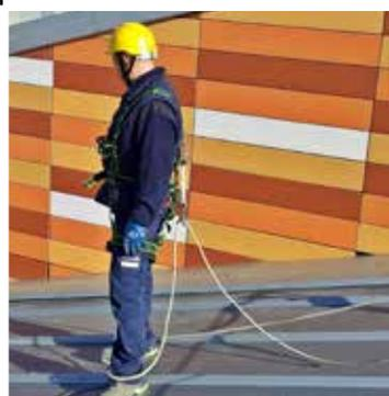
**Le risque de chute représente le risque le plus élevé entraînant des accidents graves ! Le Code du bien-être au travail est d'ailleurs éloquent à ce sujet : « ...il faut prioritairement placer des protections collectives contre les chutes. Si ce n'est pas possible, il faut alors placer des protections individuelles telles que des lignes de vie ».**
